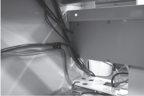
Abbildung D-8: Kabel laufen über die Innenseite des HCGG in Richtung der Module
